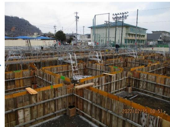
左の写真では、帯状にコンクリートを施工し、鉄筋を配置する準備が終わりました。また、建物の柱の位置にベースとなる金具が設置されています。
