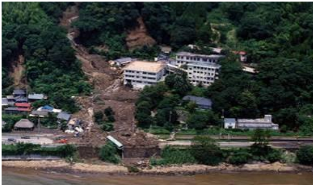
がけ崩れの直撃を受けた花倉病院 (平成5年8月豪雨 鹿児島県吉野町)
