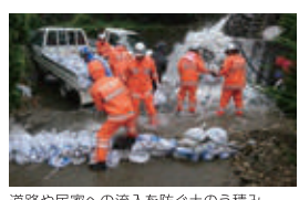
道路や民家への流入を防ぐ土のう積み
