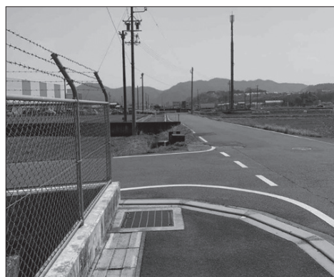
歩道整備予定の町道大針3号線
