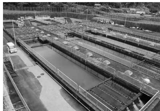
山之上浄水場(美濃加茂市)
