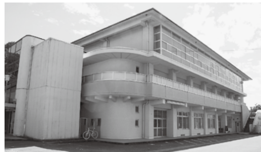
小学校体育館
