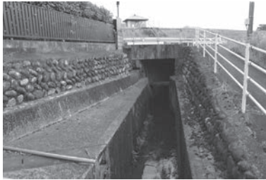
内水対策工事を予定している北島排水路(取組地内)
