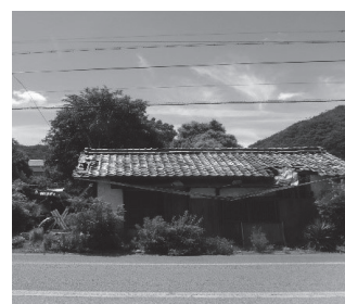
町内にあった空き家
