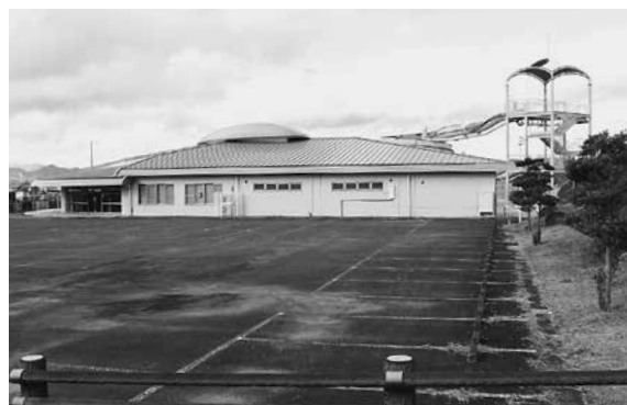
事業廃止となる町民ふれあいプール
