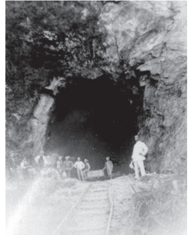
勝山のトンネル工事
