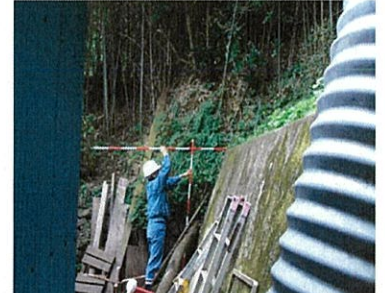
対策施設の確認
