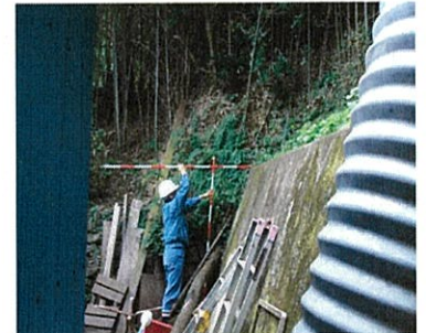
対策施設の確認
